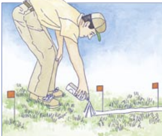
Prima di eseguire la trincea marcare il tracciato dell'impianto di innaffiamento utilizzando delle bandierine ed una bomboletta di vernice.
